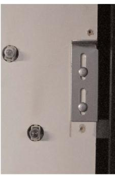
Durch hochschieben der Verriegelung öffen Sie das Lampenpanel.
